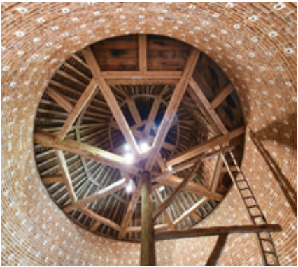
Colombier XVIIe ISMH charpente et échelle tournante
